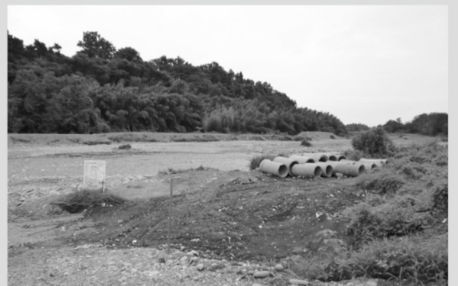
下大島・町屋地区の懸案である夏季の増水に備え、烏川・里見川の堆積土を除去。
