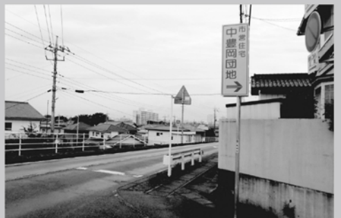
町内会との協力により、市営住宅および町内の玄関口に案内看板を設置しました。また、歩道のカタカタ部分の補修を実施しました。
