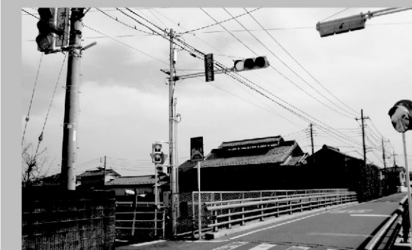
井野川サイクリングロード中川橋に押ボタン式信号を設置
