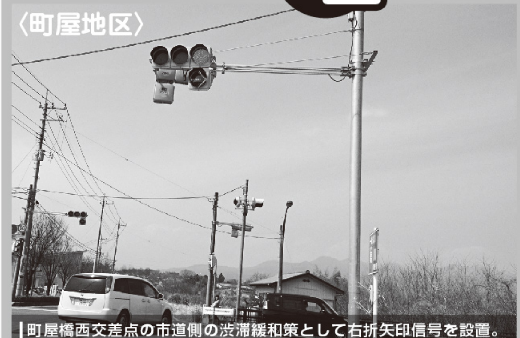
町屋橋西交差点の市道側の渋滞緩和策として右折矢印信号を設置。
