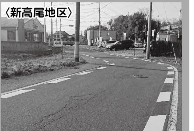
〈新高尾地区〉 新高尾小学校の通学路区間の歩道未整備区間の安全対策として、注意喚起の路面標示を実施。
