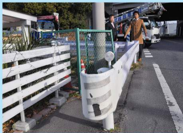
県道前橋高崎線高速ガード南側のガードレールを改修し、歩行スペースを確保しました。
