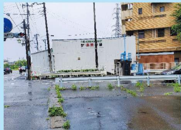
県道前橋高崎線高速ガード北側の除草対策として舗装を実施しました。
