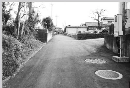
引間地区において下水道工事後の仮舗装の復旧および、豪雨時の住宅への浸水対策のため排水溝を設置
