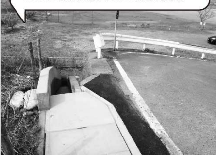
上豊岡運動広場入り口における雨水流入による土砂崩れ防止のため側溝を敷設。
