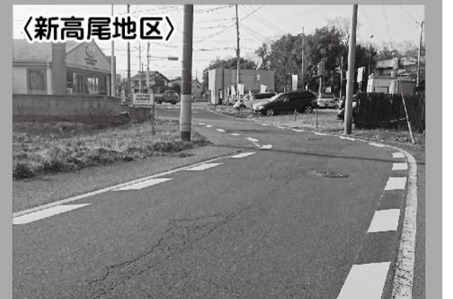
〈新高尾地区〉 新高尾小学校の通学路区間の歩道未整備区間の安全対策として、注意喚起の路面標示を実施。
