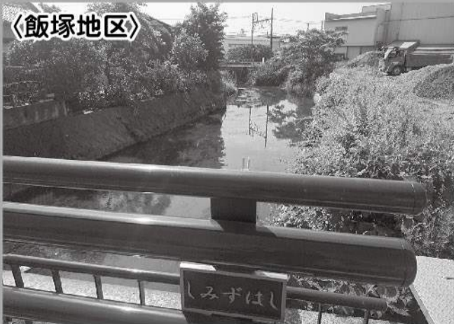
〈飯塚地区〉 一貫堀川の増水対策として、清水橋下流に大量に堆積していた土砂を除去しました。
