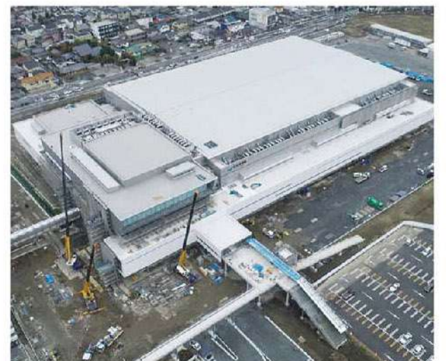
現在建設中のGメッセ群馬 (高崎競馬場跡地)
